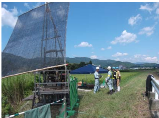
③巨勢川上流広域河川改修業務 (地質調査) (佐賀市川久保) H29.9.8
